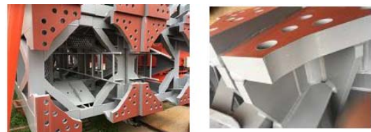
図3 ポスト材が山形鋼の場合の偏心ジョイント
