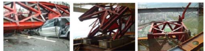
図2 タワークレーンマストのボルト接合部から崩壊したタワークレーン
