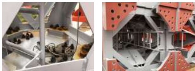
写真1 タワークレーンマスト接合部例
