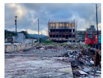
写真3 火災により焼失した輪島の朝市通り
